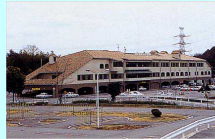
太陽猪名川自動車学校のピロティ構造
