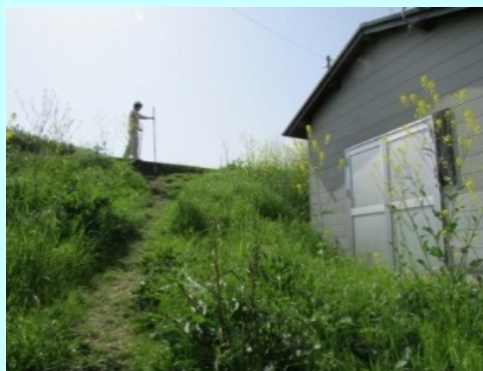
H25点検状況
