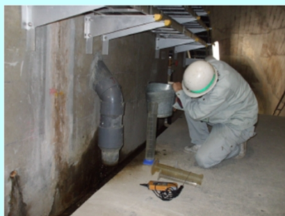
継目排水孔からの漏水量の計測
