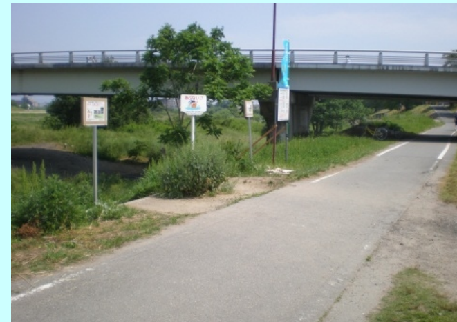
警告看板設置(桂川右岸15.8k付近)
