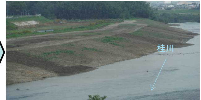
整備完了(平成26年10月下旬)
