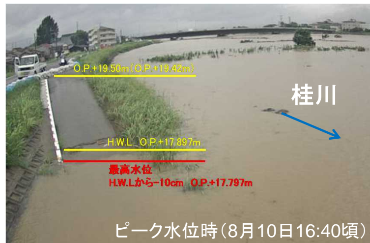
監視用カメラにおける出水時の状態
