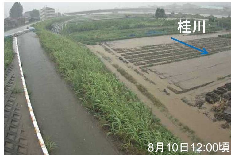
監視用カメラの設置
