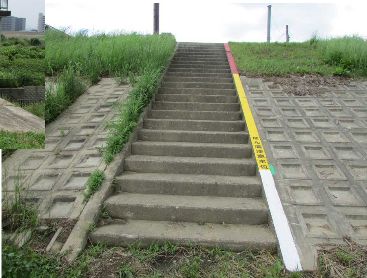
五番樋門付近階段
