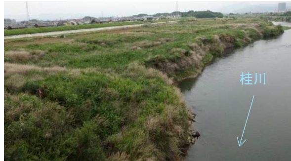
羽束師橋上流整備前の状況(平成26年7月上旬)
