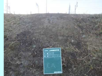
維持作業により法面復旧
