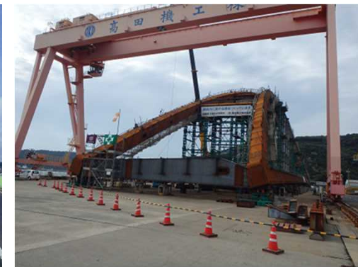
【仮組立検査状況(H28)】
