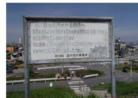
注意喚起看板(淀川) 補修前
