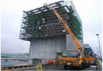
淀川大堰補修状況
