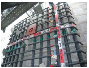
淀川大堰 堰柱耐震対策実施状況
