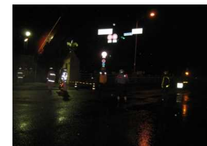
右岸陸閘閉鎖中の状況
