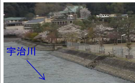
宇治川護岸状況
