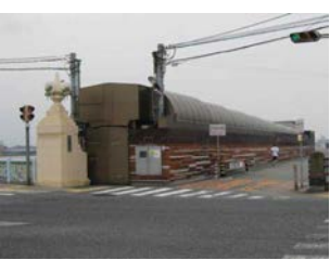
耐震対策予定 淀川陸閘（左岸）
