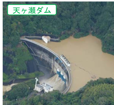
H25T18洪水におけるダム貯水池
