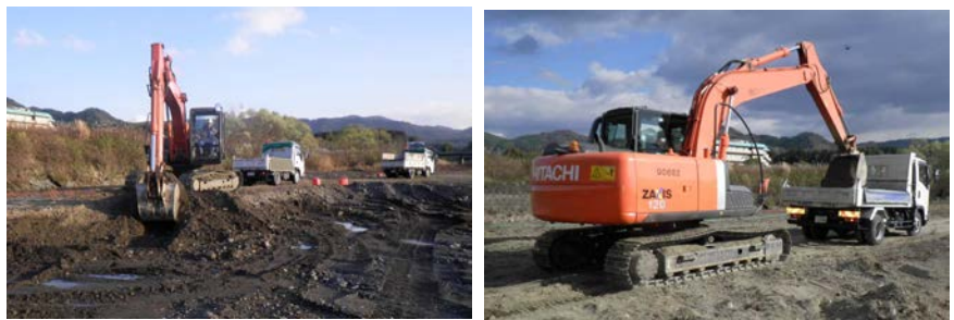
平成27年度試験施工状況
