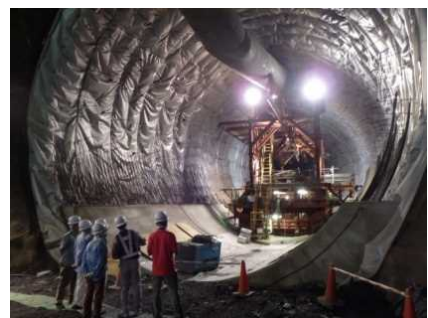
天ヶ瀬ダム再開発トンネル
