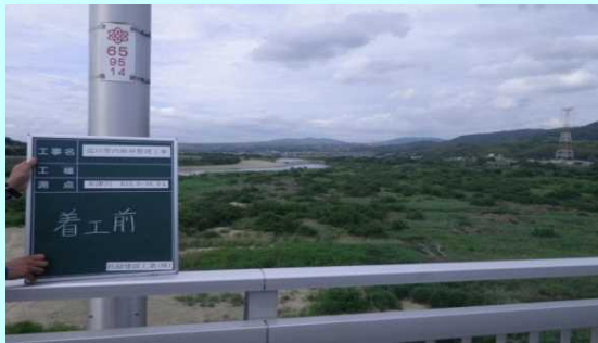
京都府綴喜郡井手町井手地先 木津川16.0k付近 右岸 着工前
