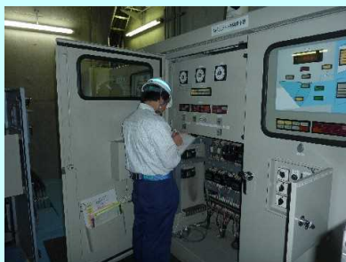
機械設備の点検
