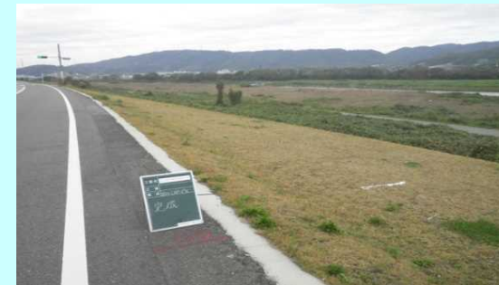
八幡市八幡科手地先 木津川0.4k付近 左岸 完成
