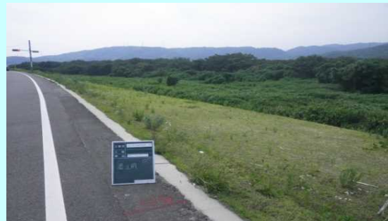
八幡市八幡科手地先 木津川0.4k付近 左岸 着工前
