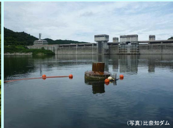
深層曝気設備(室生ダム、布目ダム、比奈知ダム)
