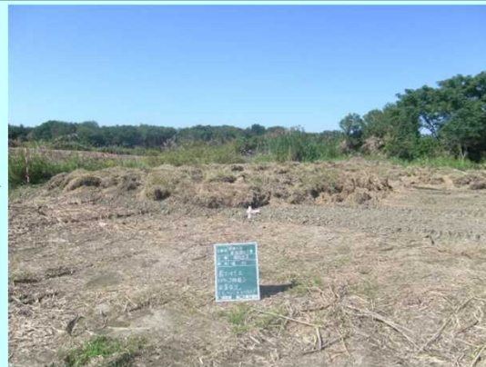
②表土の保管状況
