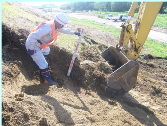
①表土の剥ぎ取り状況
