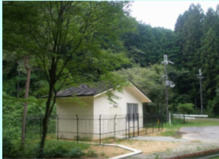
平成21年度 室生ダム曝気設備上屋(貯水池中流)の新設
