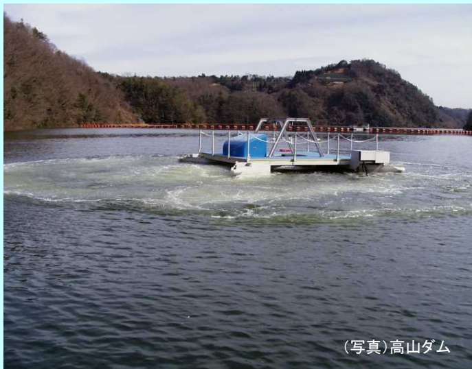
浅層曝気設備(高山ダム、室生ダム、布目ダム)
