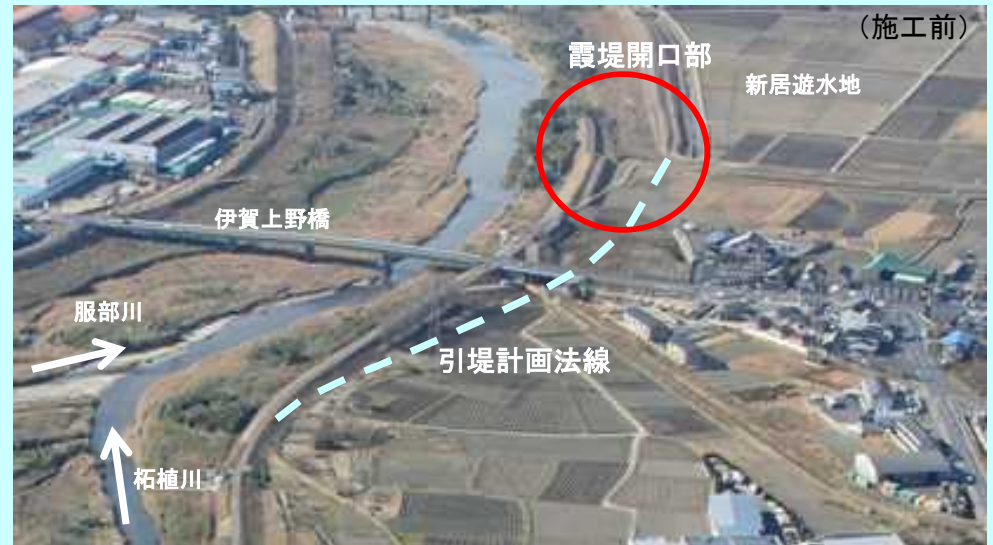
服部川霞堤締切り施工状況 (服部川右岸1.4k+100m付近)
