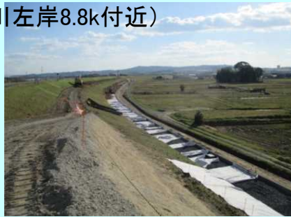
施工中(ドレーン工設置)
