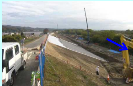
施工中(遮水シート設置)
