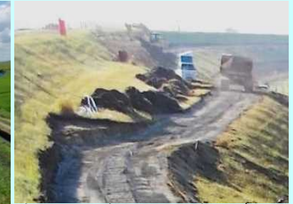
車両通行路においてもチガヤ群の表土を保存した上で、通行
