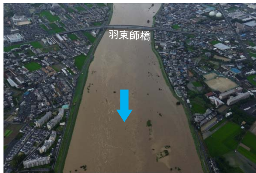
羽束師橋下流付近(5k付近、17時頃)
