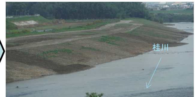
整備完了(平成26年10月下旬)
