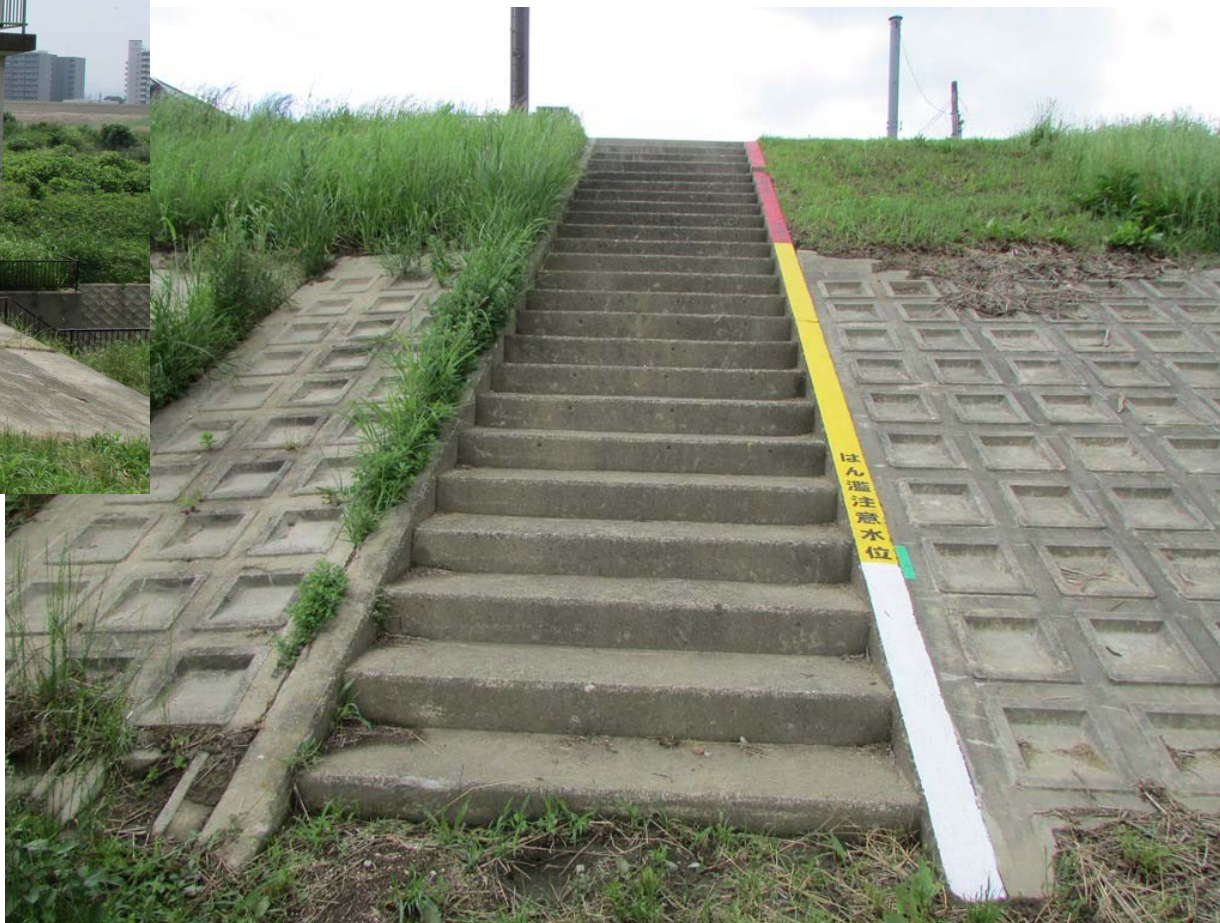
五番樋門付近階段
