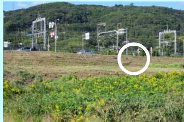
除草後には法面異常箇所を発見しやすくなる
