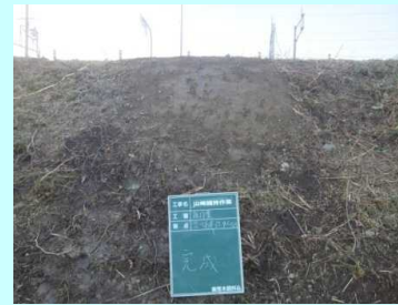
維持作業により法面復旧
