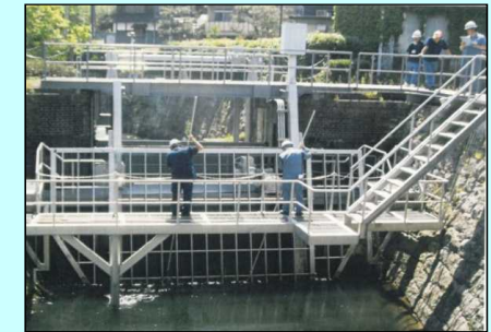
琵琶湖第一疏水制水ゲートの点検状況
