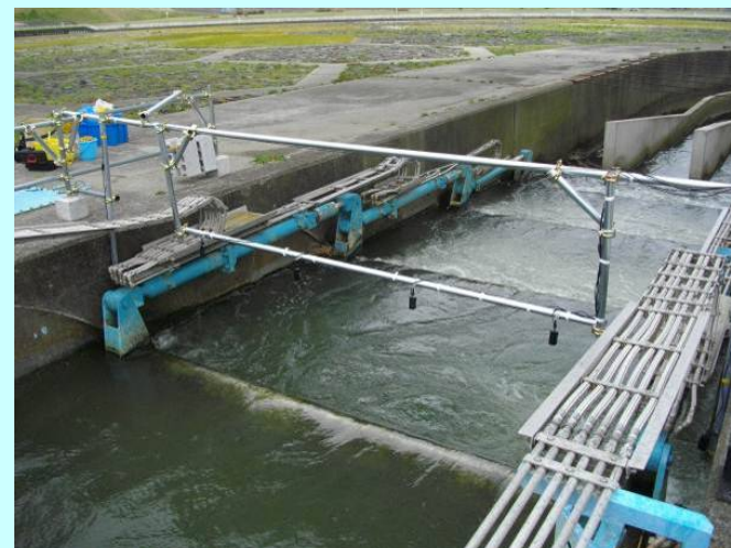
カメラによるモニタリング状況
