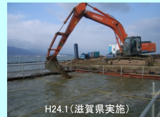
③覆砂として土砂を湖底へ投入 <草津市下笠地先>
