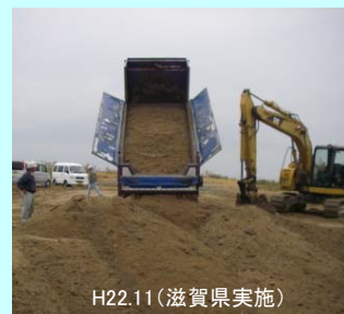
③覆砂として土砂を湖底へ投入 <草津市下笠地先>
