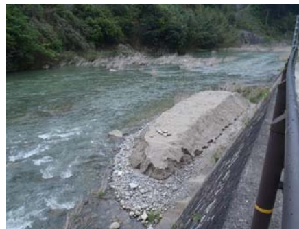
置土状況 フラッシュ放流前 (H24.5.6撮影、比奈知ダム下流)
