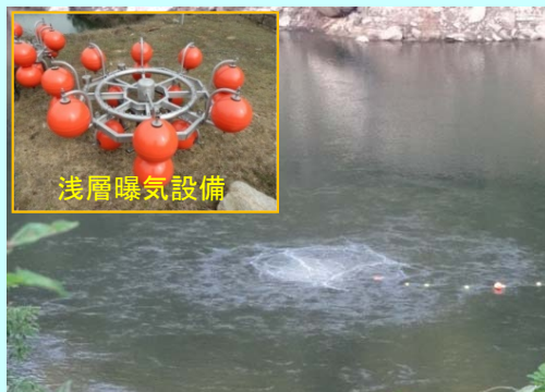
高山ダム 曝気増設状況
