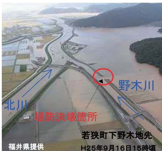
北川水系野木川 堤防決壊
