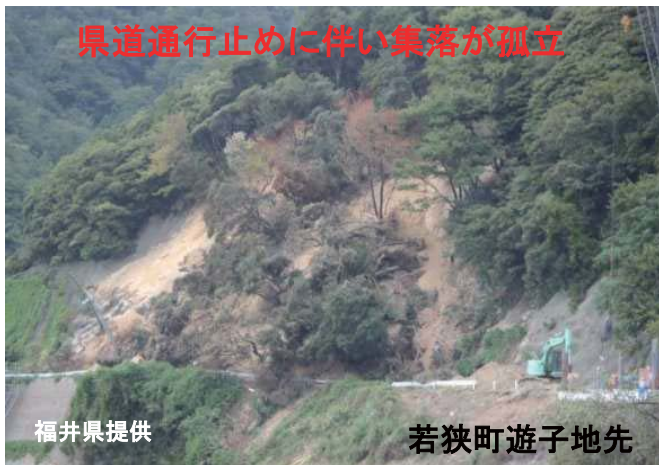
常神半島 法面崩壊発生状況
