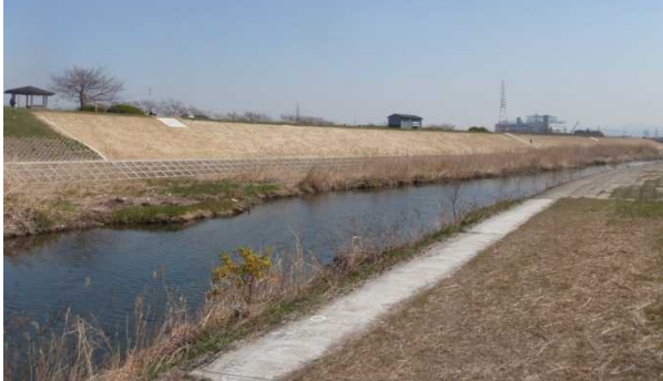
【淀川河川事務所】 淀川(芥川)南庄所地区(芥川左岸2k付近) 堤防強化工事施工後
