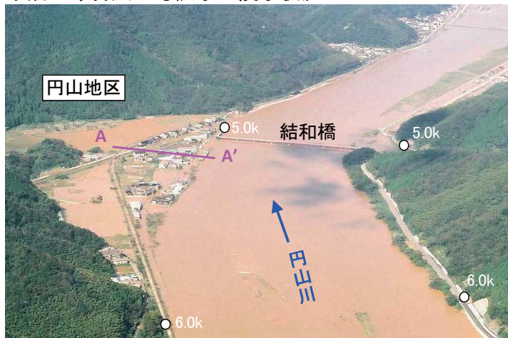
平成16年台風23号洪水の浸水状況
