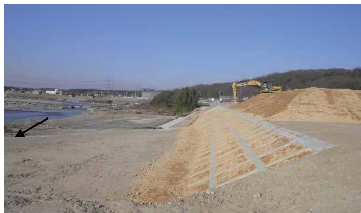
（左岸 築堤事業）
