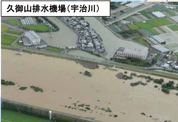
大川地区救急排水(木津川)
