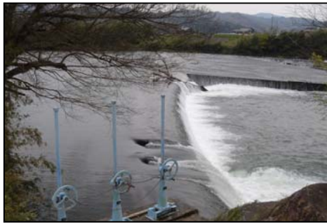
農業用河川工作物応急対策事業による堰改修に伴う慣行水利権の許可水利権化（H23年度）
