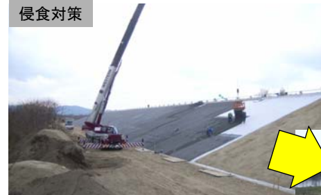
ブロックマットの設置
