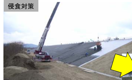
ブロックマットの設置
