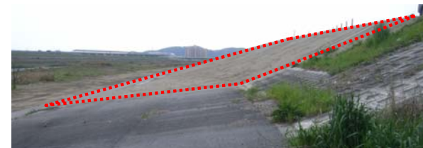
断面拡大工法
