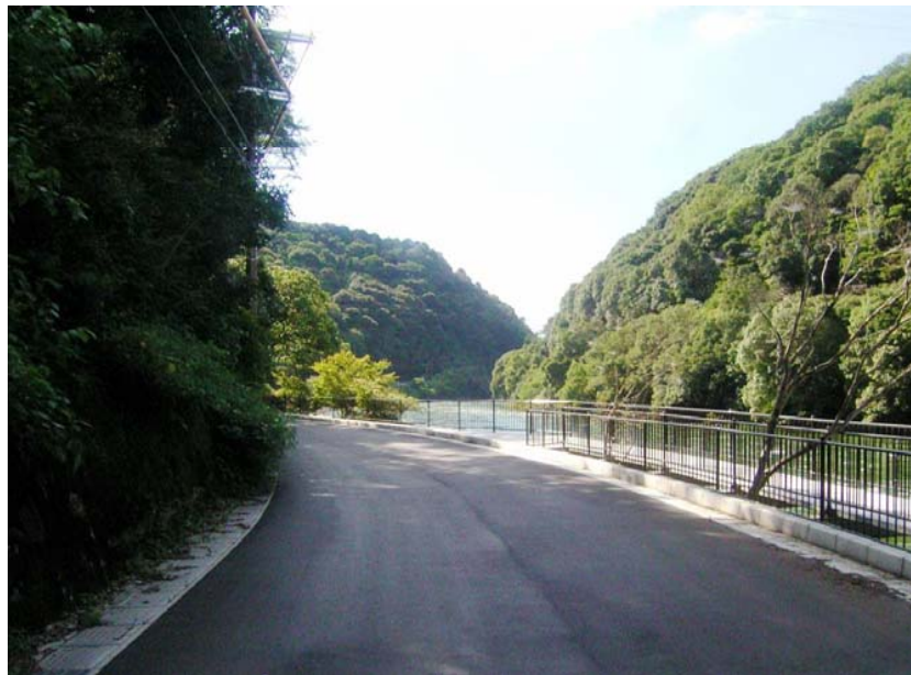
左岸工事用道路 整備状況
