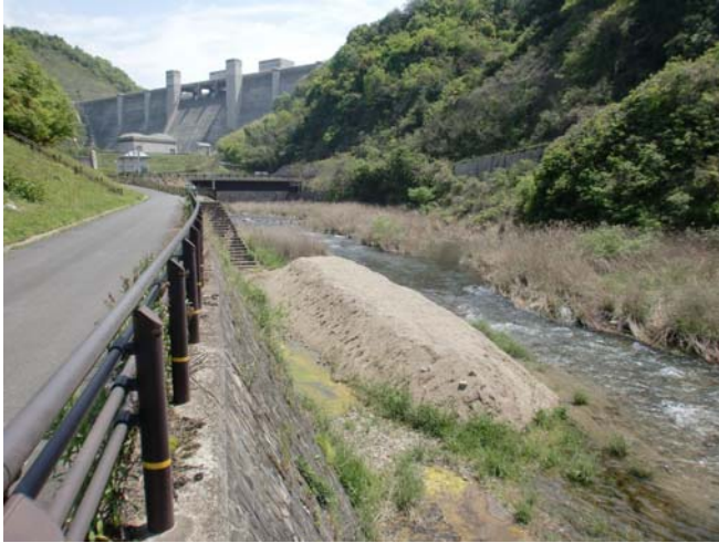
置土状況 フラッシュ放流前 (H23.5.13 撮影、比奈知ダム下流)
