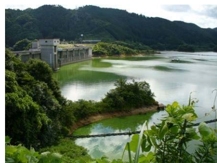
写真-1 布目ダムのアオコ発生状況 (平成19年8月)
