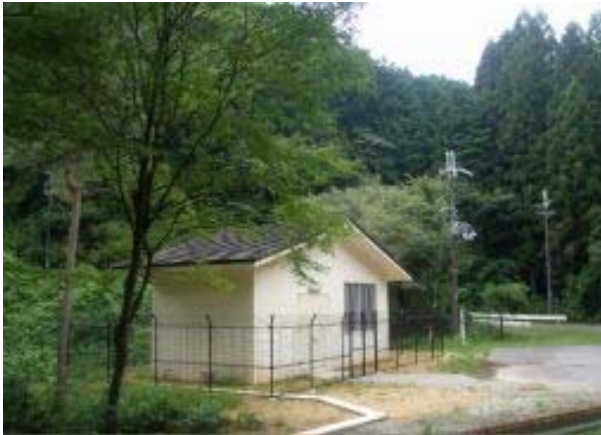
室生ダム曝気設備上屋（貯水池中流）
