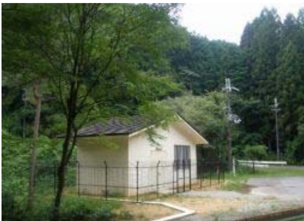
室生ダム曝気設備上屋(貯水池中流)
