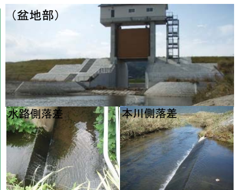
写真-1 支川との落差の例(上野遊水地)
