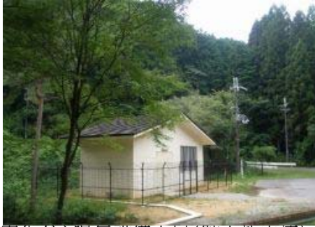
室生ダム曝気設備上屋(貯水池中流)
