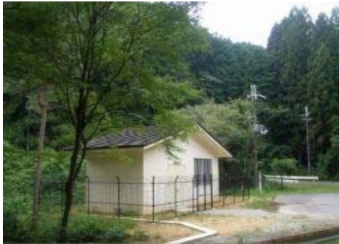
室生ダム曝気設備上屋(貯水池中流)
