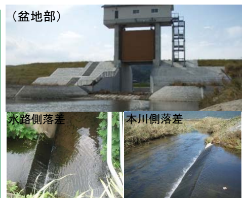
写真-1 支川との落差の例(上野遊水地)
