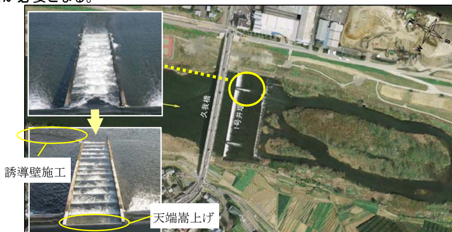
写真-1 魚類等の移動阻害改善の例 (桂川1号井堰)
