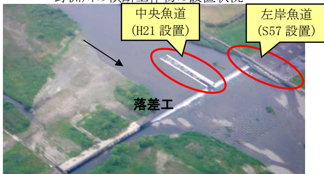
魚道の設置状況
