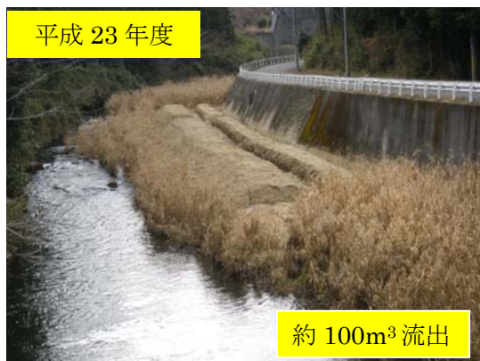
布目ダム出水後の土砂状況（整形後）
