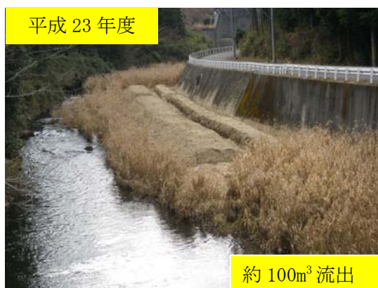
布目ダム出水後の土砂状況（整形後）
