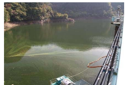
写真-1 室生ダムのアオコ発生状況 (平成 20 年 11 月)
