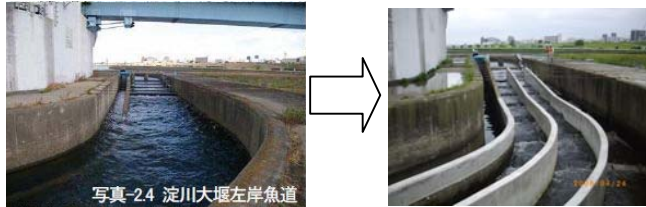
写真-24 淀川大堰左岸魚道
