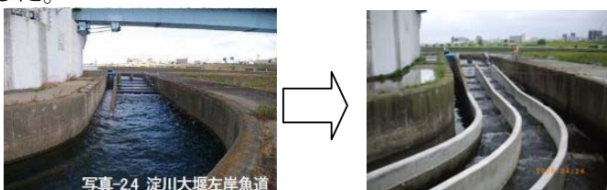
写真-24 淀川大堰左岸魚道
