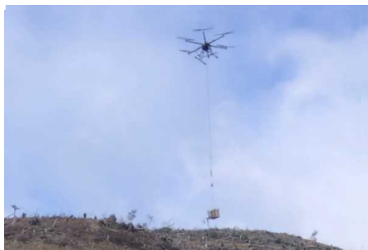
ドローンによる資材運搬
