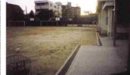
平常時の流域貯留施設(瓜破中学校校庭)
