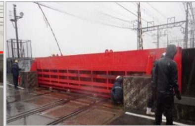
陸閉鎖完了 台風21号(H30年)
