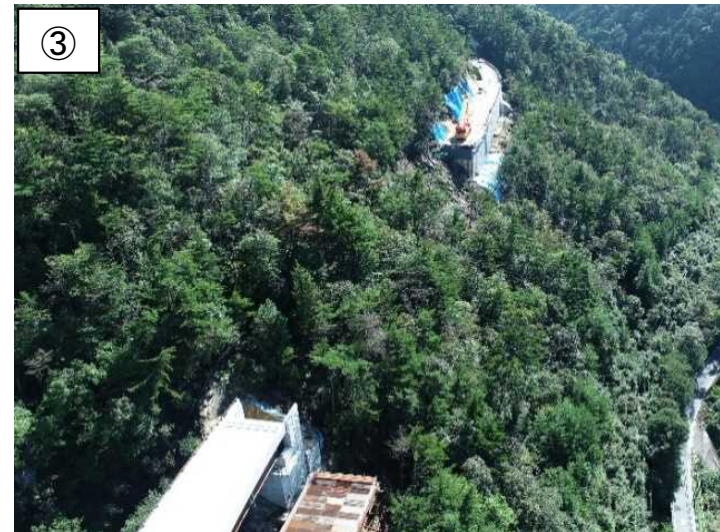
新7,8号橋間道路改良工事(令和3年10月時点)
