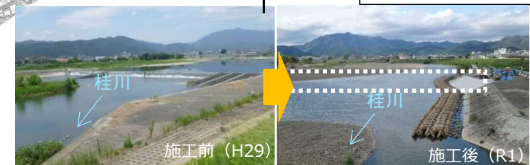
4号井堰の状況
