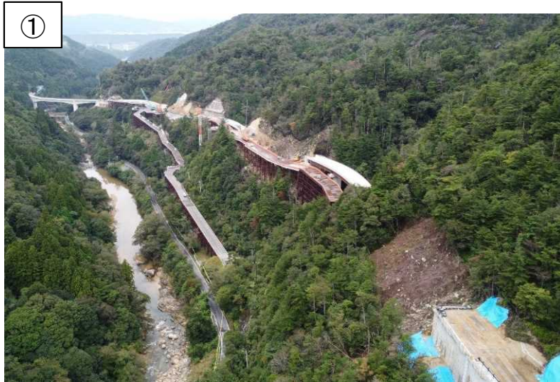
残工事区間全景(令和3年10月時点)
