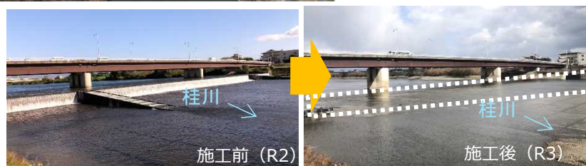
1号井堰の状況
