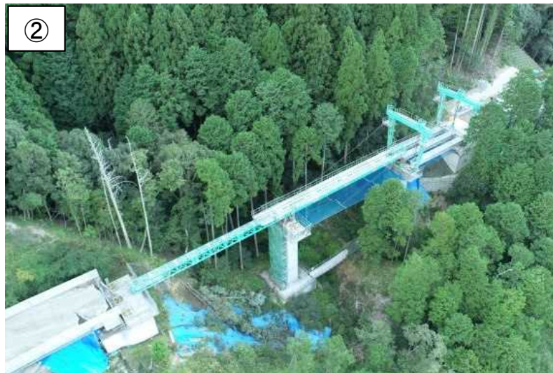
新2号橋上部工事(令和3年10月時点)
