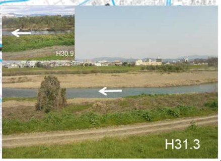
環境、土砂流出への配慮
