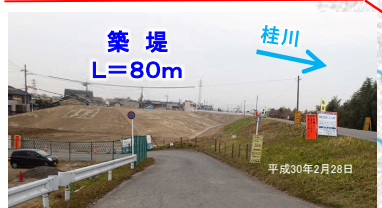
大下津地区築堤
