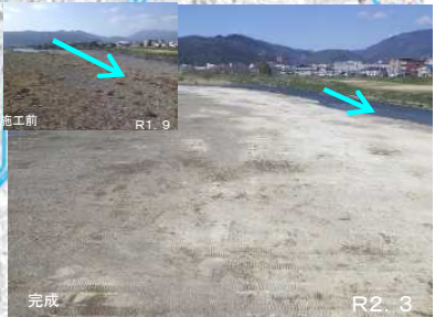
環境、土砂流出への配慮
