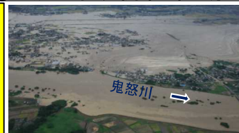
鬼怒川の堤防決壊による 浸水被害 (茨城県常総市)
