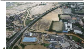
桂川における浸水被害 (福岡県朝倉市)
