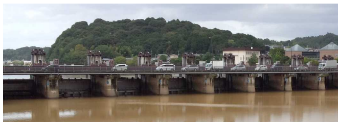
写真 3.3.1-1 瀬田川洗堰全閉操作(平成 25 年台風 18 号)
