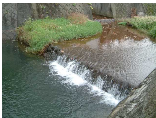
写真 4.2.3-9 瀬田川 流入支川合流部
