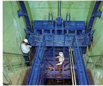
ゲートの点検状況
