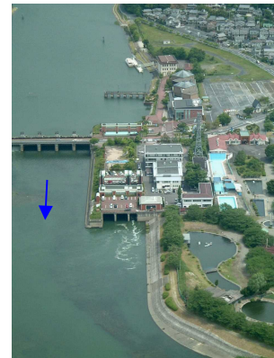
写真 4.3.2-8 瀬田川洗堰のバイパス水路
