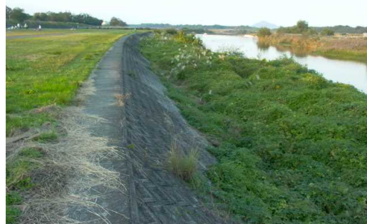
写真 3.2.7-1 コンクリート護岸
