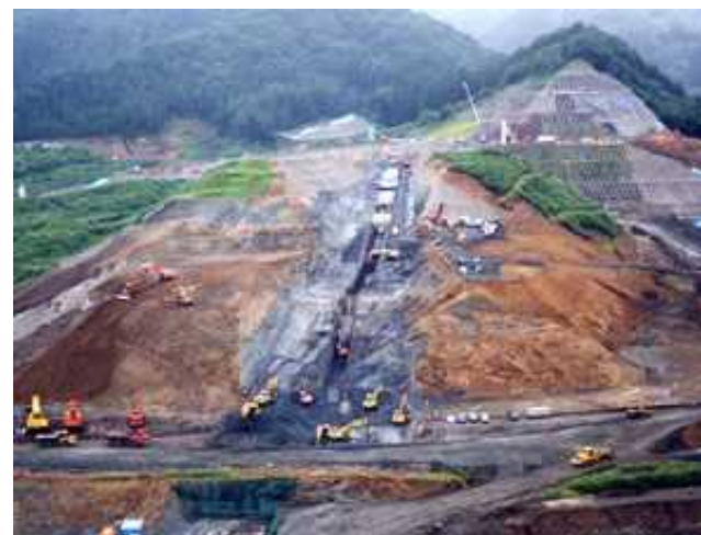
基礎掘削（他ダム事例）
