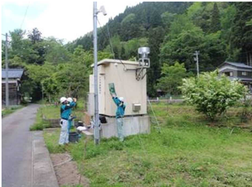
雨量観測所写真（他ダム事例）
