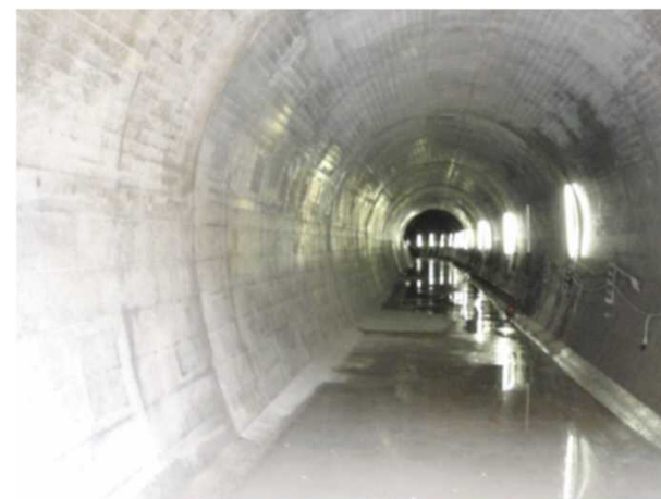
仮排水路内部施工状況 (他ダム事例)
