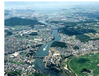
写真2-3 瀬田川(琵琶湖～瀬田川洗堰付近)
