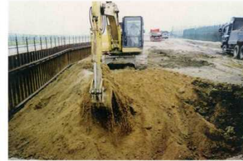
写真 3.3.1-13 木津川の堤防の状況
