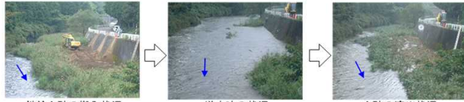
供給土砂の搬入状況
