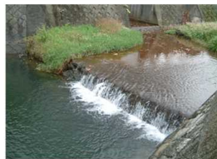
写真 4.2.3-9 瀬田川 流入支川合流部
