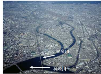
写真 2-9 猪名川・神崎川合流部
