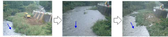
供給土砂の搬入状況
