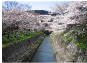
写真2-10 琵琶湖疏水の取水口
