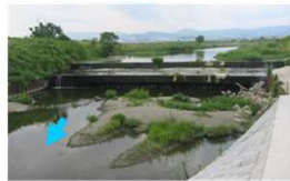
写真 4.2.3-7 縦断方向の河川形状の修復 (芥川1号井堰)
