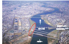
写真 4.3.4-1 淀川大堰閘門設置位置
