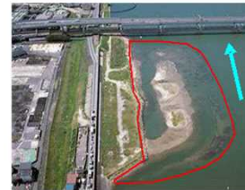
写真4.2.3-3 干潟再生(海老江地区の事例)
