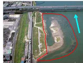
写真4.2.3-3 干潟再生(海老江地区の事例)
