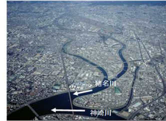
写真 2-9 猪名川・神崎川合流部
