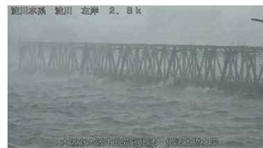
写真 3.3.2-1 平成30年台風21号時の阪神電鉄なんば線橋梁の状況
