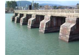
写真 4.6.2-4 旧瀬田川洗堰(南郷洗堰)
