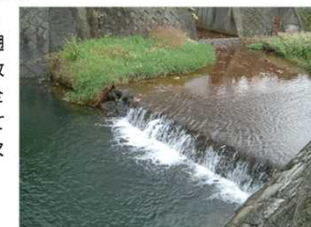
写真 4.2.3-9 瀬田川 流入支川合流部
