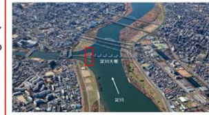
写真 4.3.4-1 淀川大堰閘門設置位置
