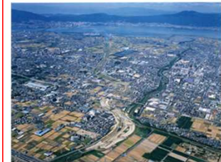
写真 3.3.1-6 草津川(分派部)
