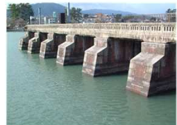
写真 4.6.2-4 旧瀬田川洗堰(南郷洗堰)
