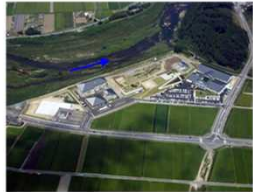
写真 4.3.2-4 名張川河川防災ステーション
