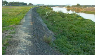
写真 3.2.7-1 コンクリート護岸
