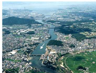
写真2-3 瀬田川(琵琶湖～瀬田川洗堰付近)
