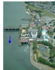
写真 4.3.2-8 瀬田川洗堰のバイパス水路
