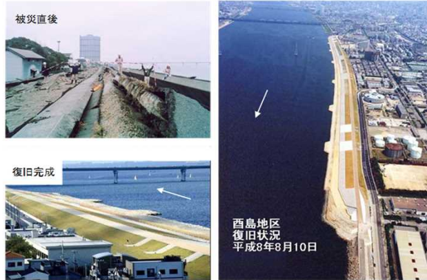
写真 3.3.3-1 西島地区災害復旧工事状況
