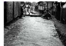
写真 3.3.1-11 相模川(昭和 47 年 9 月 床下浸水 898 戸)
