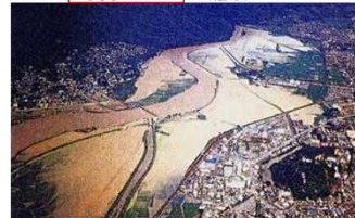
写真 3.3.1-4 亀岡市街上空から (昭和57年8月台風10号)
