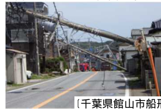
【台風等による電柱倒壊状況】
