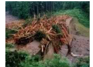
流木捕捉式治山ダム
