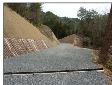
【森林整備：林道(整備)】
