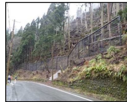
【落石防護柵の設置】
