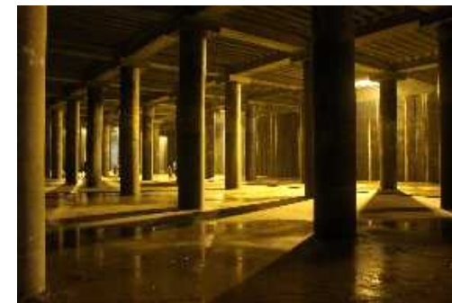
貯留施設の整備
