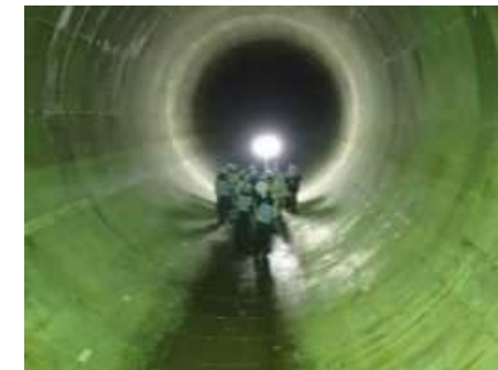
雨水貯留管の整備
