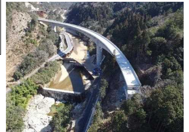
付替県道大津信楽線 牧町天空大橋 (新3号橋)
