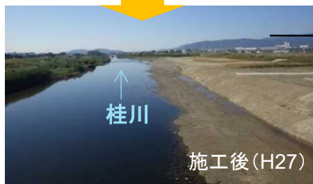
羽束師橋下流の状況
