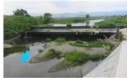
写真 4.2.3-7 縦断方向の河川形状の修復 (芥川1号井堰)
