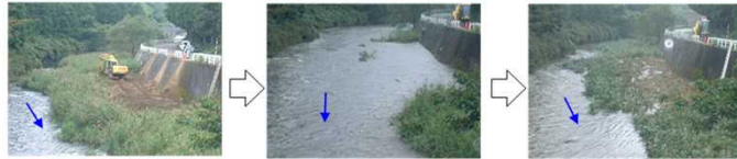
供給土砂の搬入状況
