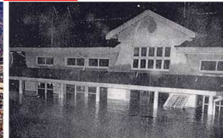
写真 3.3.1-5 亀岡駅 (昭和28年9月台風13号)
