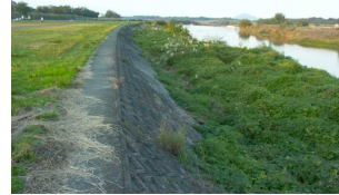
写真 3.2.7-1 コンクリート護岸
