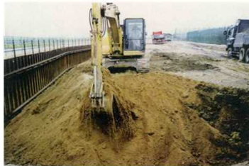
写真 3.3.1-9 木津川の堤防の状況
