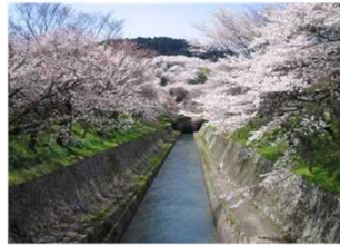
写真2-10 琵琶湖疏水の取水口
