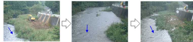
供給土砂の搬入状況
