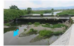
写真 4.2.3-8 縦断方向の河川形状の修復 (芥川1号井堰)
