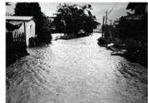
写真 3.3.1-8 堂の川(昭和 44 年 8 月 全壊家屋 1 戸、床上浸水 11 戸)
