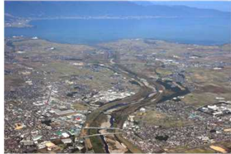
写真 3.3.1-5 野洲川(放水路区間)
