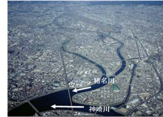
写真 2-9 猪名川・神崎川合流部
