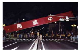
写真 3.3.2-2 淀川陸間ゲート
