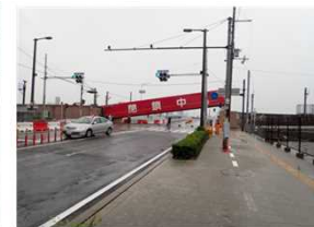
写真 3.3.2-2 淀川陸間ゲート (平成30年9月)
