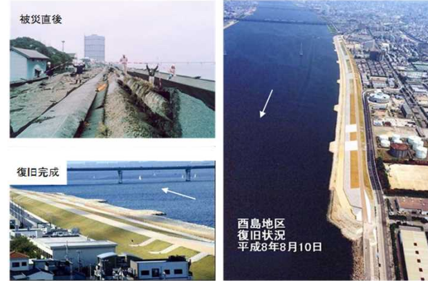
写真 3.3.3-1 西島地区災害復旧工事状況
