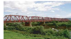
写真 3.6-2 河道内樹木の繁茂状況(木津川)
