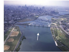
写真 3.2.3-1 淀川大堰から下流を望む
