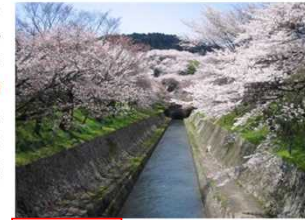
写真2-12 琵琶湖疏水の取水口
