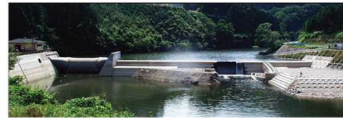
写真 4.2.5-4 副ダム（室生ダム）
