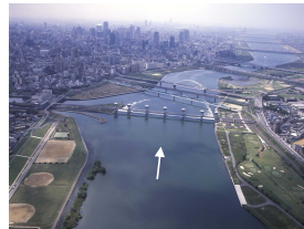
写真 3.2.3-1 淀川大堰から下流を望む
