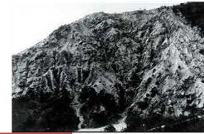
写真 3.3.1-16 三上山の荒廃状況(大正4年)
