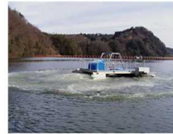
写真 4.2.5-3 循環曝気設備稼働状況
