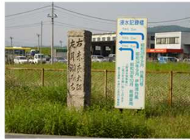
写真 4.3.2-2 浸水実績水位の表示例
