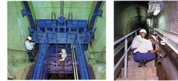
ゲートの点検状況 本体の観測・点検状況 写真 4.6.2-1 ダムの管理状況
