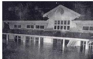
写真 3.3.1-4 亀岡駅 (昭和28年9月台風13号)
