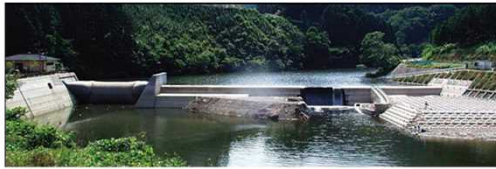
写真 4.2.5-4 副ダム（室生ダム）
