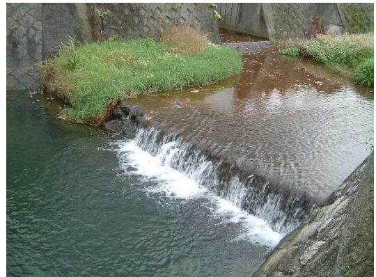
写真 4.2.3-9 瀬田川 流入支川合流部
