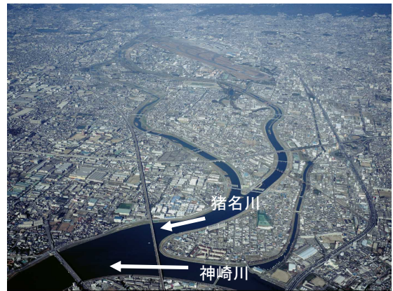
写真 2-9 猪名川・神崎川合流部
