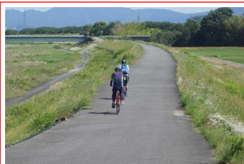
写真 4.1.2-3 堤防天端を通行する自転車 (野洲川)
