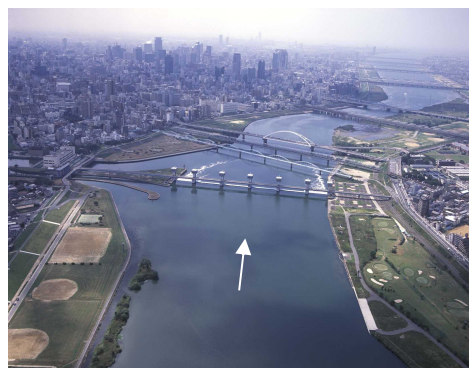
写真 3.2.3-1 淀川大堰から下流を望む
