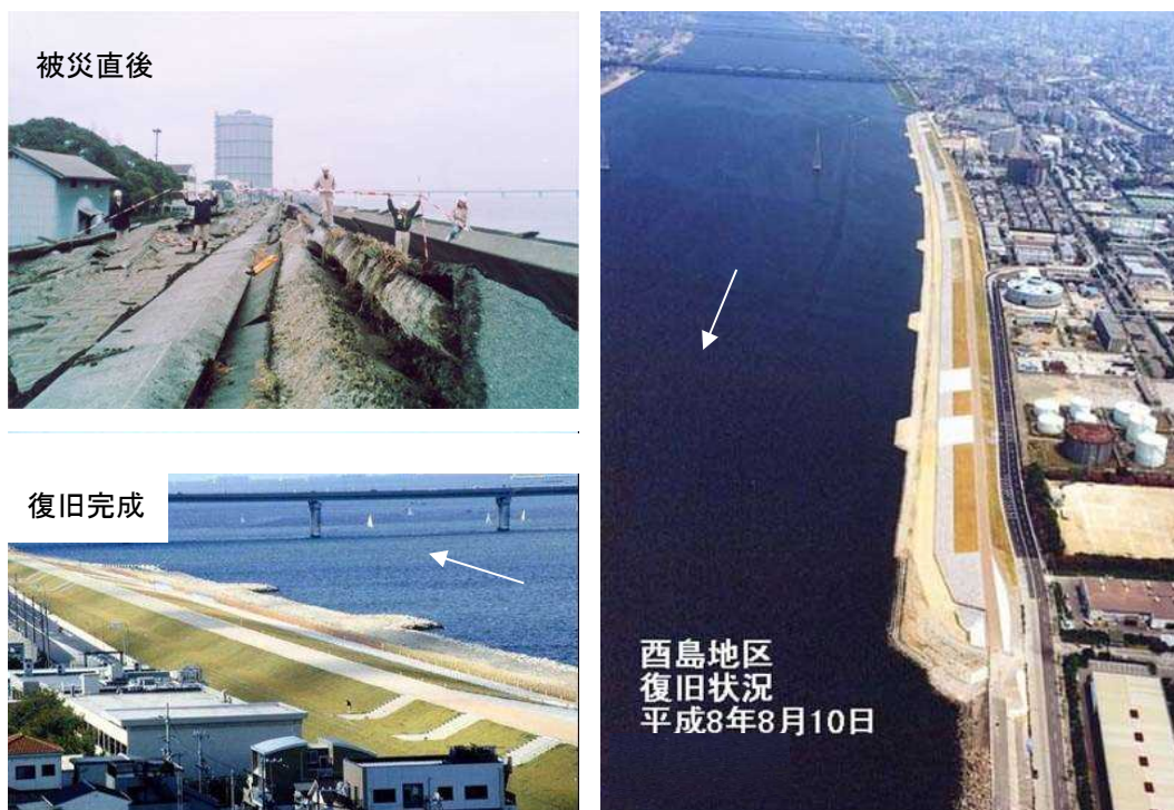
写真 3.3.3-1 西島地区災害復旧工事状況
