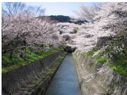
写真 2-12 琵琶湖疏水の取水口
