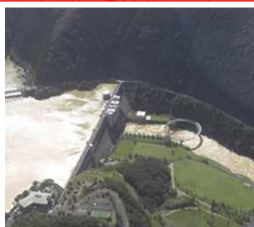
写真 2-10 日吉ダム (平成 25 年台風 18 号)
