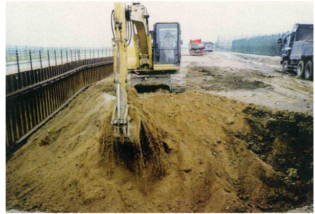
写真 3.3.1-13 木津川の堤防の状況
