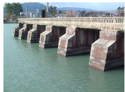
写真 4.6.2-4 旧瀬田川洗堰(南郷洗堰)
