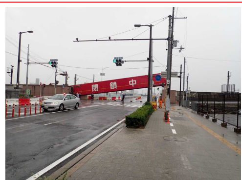
写真 3.3.2-2 淀川陸閘ゲート (平成30年9月)
