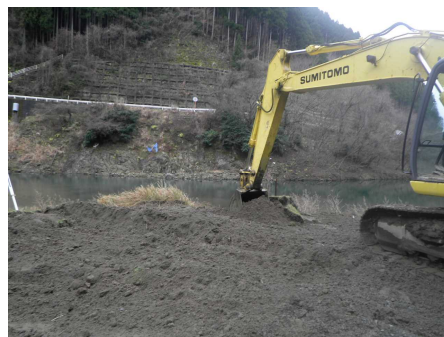
堆砂除去状況(R2.3)
