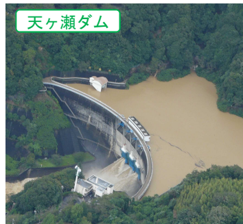
H25T18洪水におけるダム貯水池
