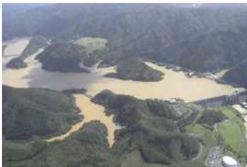
平成25年9月台風18号による貯水池状況
