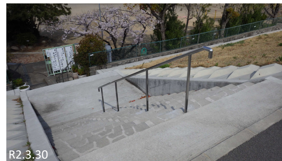
新設された手摺り(R1)
