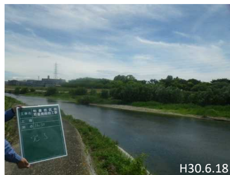
利倉・岩屋地区河道掘削(H29・H30)
