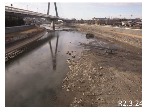
小戸・木部地区河道掘削(R1)
