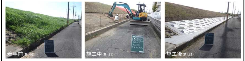
■施工写真(猪名川右岸1.2k付近)
