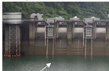
洪水貯留開始直後の貯水池の状況 (7月5日8時)
