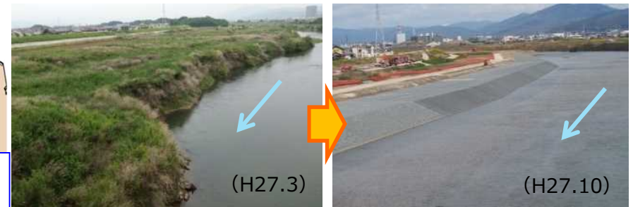
羽束師橋上流の掘削状況
