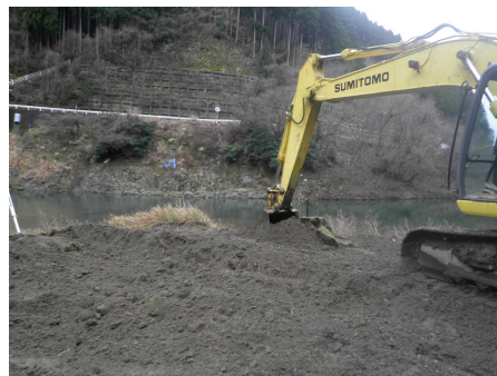
堆砂除去状況 (R2.3)
