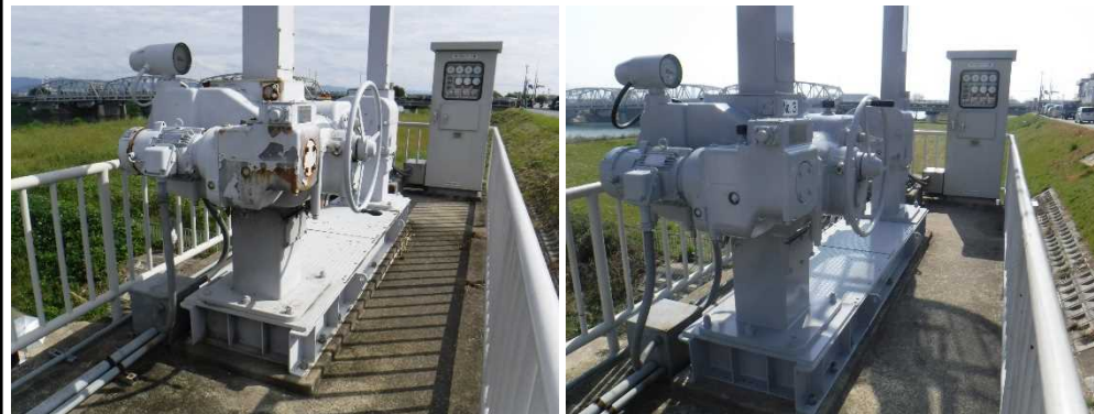
対策前(新川樋門 開閉器)
