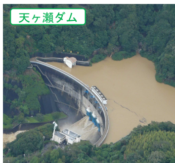
H25T18洪水におけるダム貯水池
