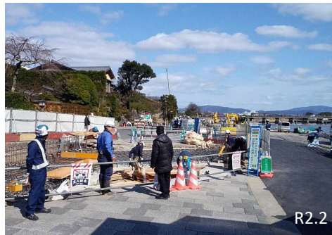
地元との綿密な調整及び 工事状況の共有
