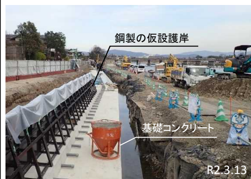
基礎コンクリート及び仮設護岸 設置状況
