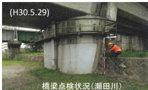
橋梁点検状況(瀬田川)
