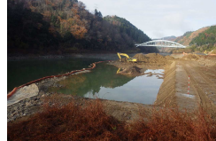
①継続的な堆砂土砂撤去
