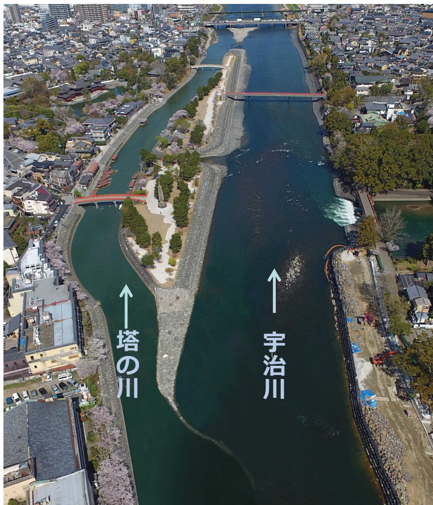
改修後の塔の島全景
