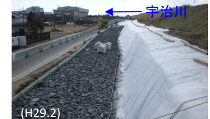
浸透対策整備状況(ドレーン工)
