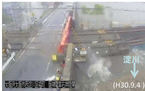
阪神陸閘の閉鎖状況 (H30.9.4)
