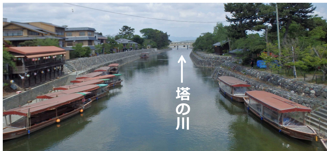
改修後の塔の川
