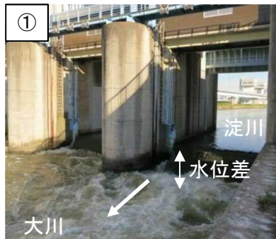
大川への流量調節を担う毛馬水門を境に淀川本川と大川に水位差が発生
