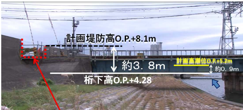
橋梁部分は堤防切り欠き
