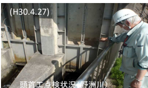
頭首工点検状況(野洲川)
