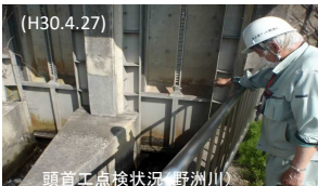
頭首工点検状況(野洲川)
