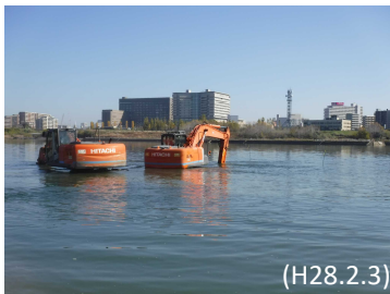
堆積土砂掘削状況(枚方地区)
