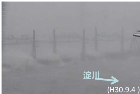
平成30年台風21号の高潮による 阪神なんば線淀川橋梁の橋桁の越波状況
