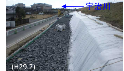
浸透対策整備状況(ドレーン工)
