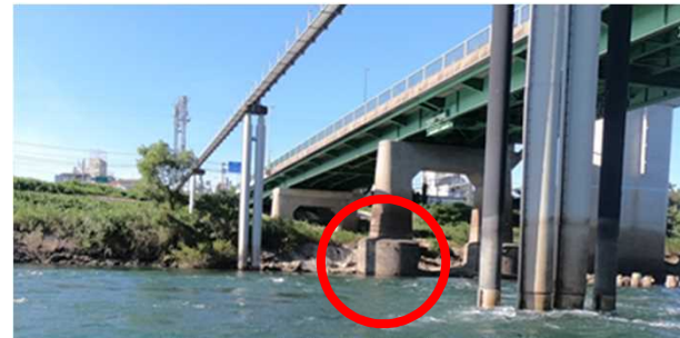
橋脚の基礎の露出(観月橋)
