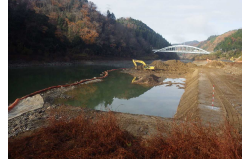
①継続的な堆砂土砂撤去
