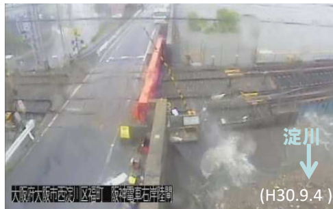
阪神陸閘の閉鎖状況
