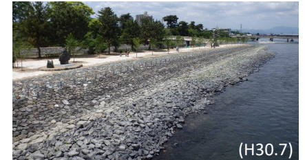
宇治川左岸塔の島(改修後)
