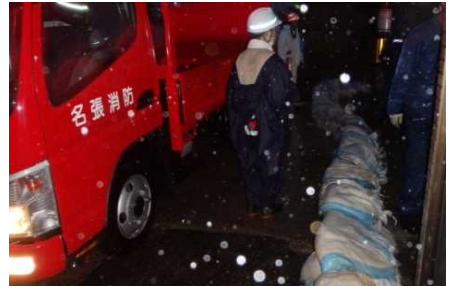
土のう設置状況(名張消防)
