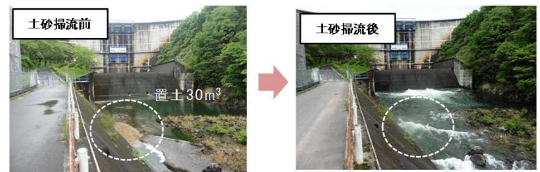
フラッシュ放流及び土砂還元実施状況(平成28年度 青蓮寺ダム)
