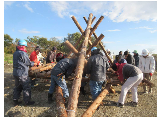
丸太材を三角錐状に組み上げ
