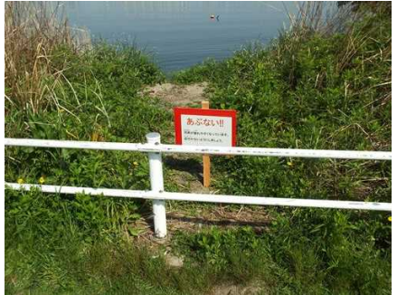
注意喚起看板の補修
