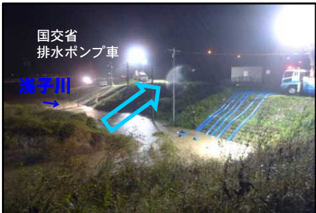
排水ポンプ車稼働状況 (平成29年10月台風21号)
