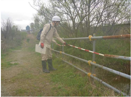
安全利用点検(横断防止柵)
