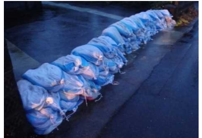
土のう設置完了(家屋浸水防止)
