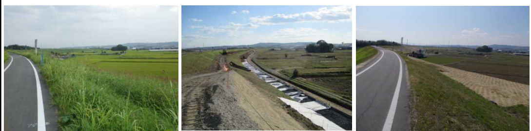
施工前 施工中(ドレーン工設置) 施工後
