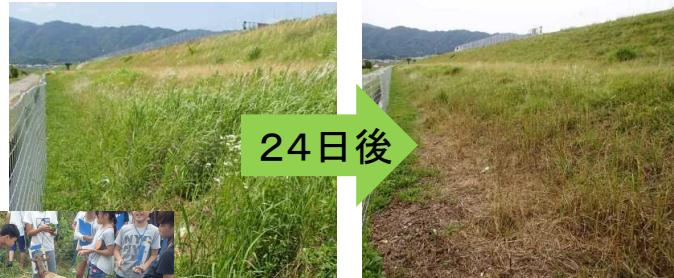
堤防維持管理の効率化に向けた取り組み(ヤギによる除草)
