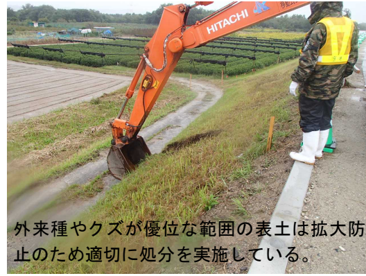
外来種やクズが優位な範囲の表土は拡大防止のため適切に処分を実施している。チガヤ群落が確認された箇所における表土はぎの実施状況
