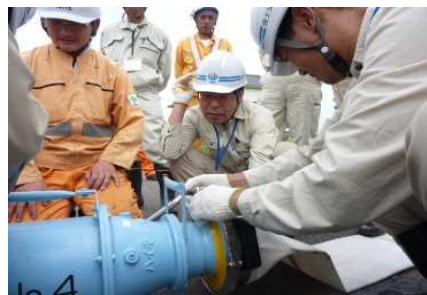
排水ホース接続訓練
