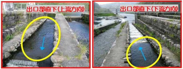
改良前の状況(平成27年6月)
