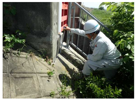
樋門点検 (大山崎樋門、H28年11月)
