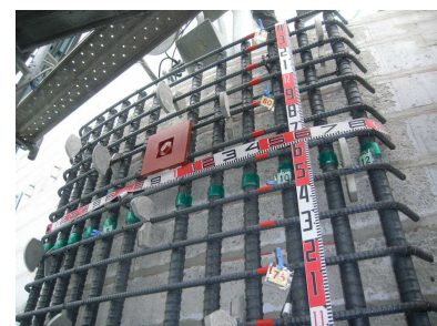
耐震対策の事例 淀川大堰堰柱耐震対策実施状況
