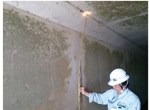
樋門・樋管の点検 (新川樋門)
