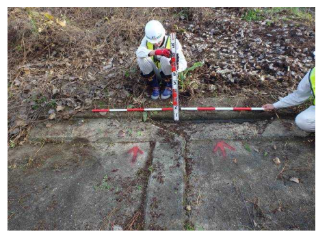
堤防点検 (桂川左岸3.2km、H28年11月)
