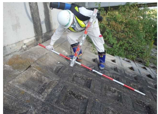
護岸の点検 (桂川右岸12.2km)
