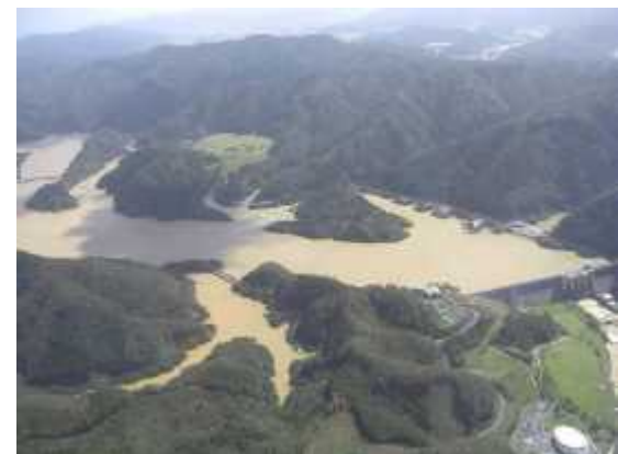
平成25年9月台風18号による貯水池状況
