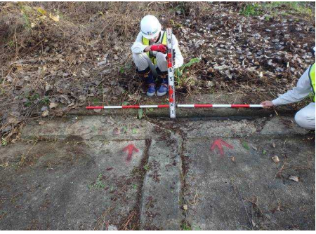
堤防点検 (桂川左岸3.2km、H28年11月)
