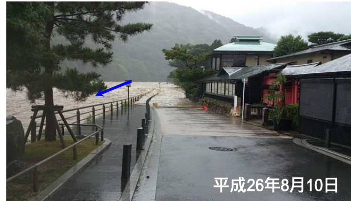
被害状況(平成26年)嵐山溢水状況
