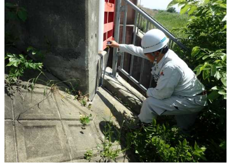
樋門点検 (大山崎樋門、H28年11月)
