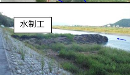
長さ30m:川幅約300mに対して10%ただし最上流のみ15m
