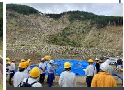
ソイルセメントの試験施工
