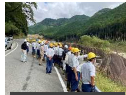
床固工の施工状況を確認
