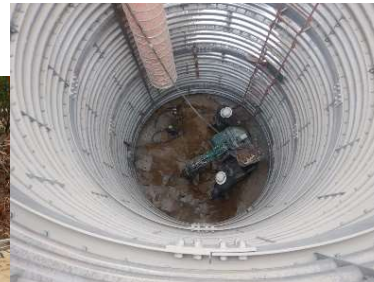
山腹工 (掘削状況)
