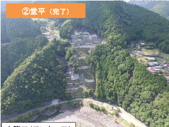
山腹工(アンカー工)
