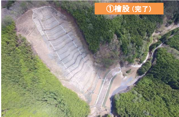
溪間工(コンクリート谷止工・かご枠護岸工・鋼製枠帯工) 山腹工(土留工・法枠工・緑化工)
