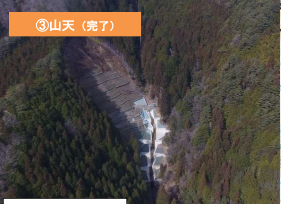
溪間工(谷止工)
