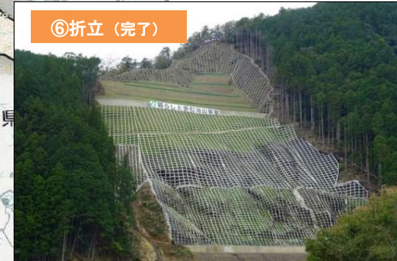
山腹工(法枠工・土留工・緑化工)
