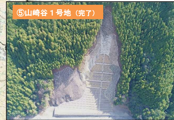
山腹工(法枠工・モルタル吹付工・緑化工) 溪間工(護岸工)
