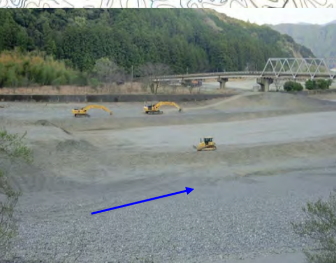
本宮地区 土砂撤去
