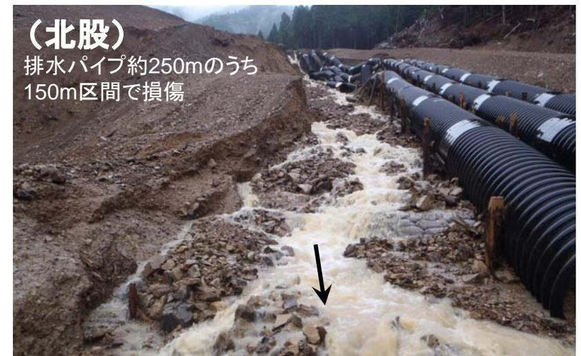
河道閉塞部の表面侵食により、排水パイプが一部損傷。
