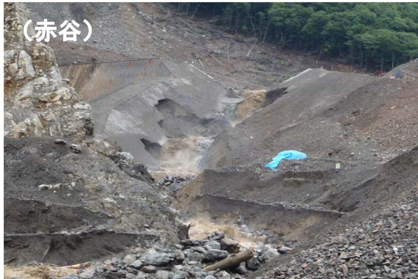
仮排水路からの排水状況と末端部の洗掘
