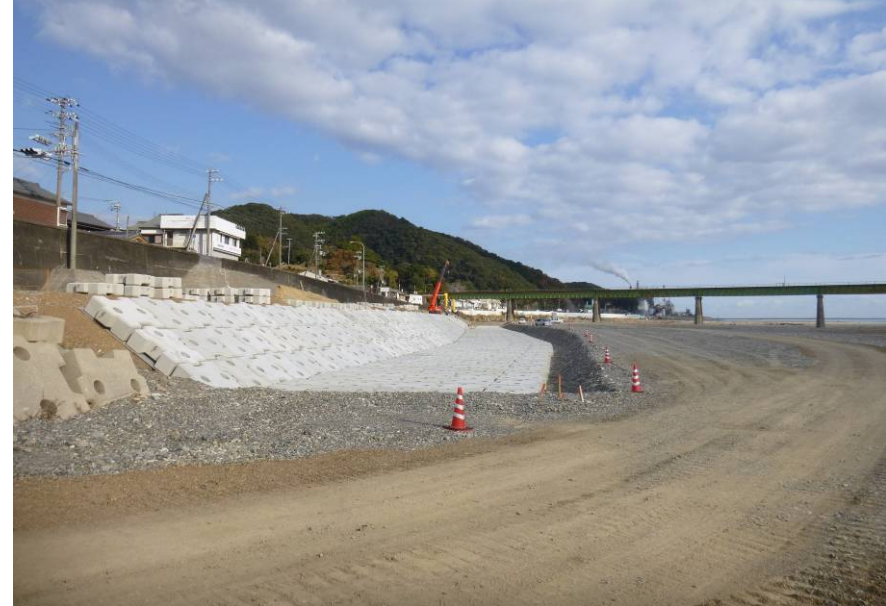
成川地区護岸災害復旧工事状況
