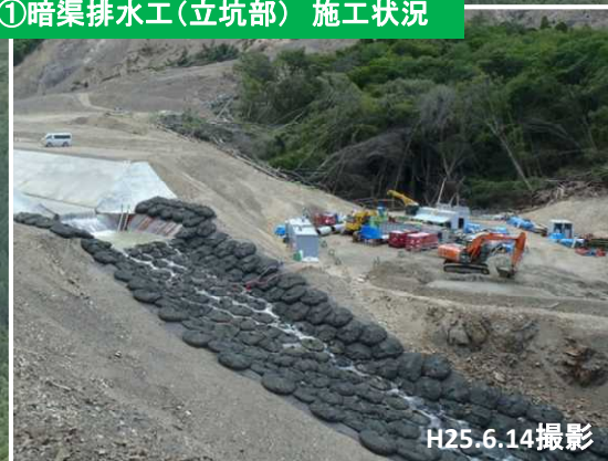
①暗渠排水工(立坑部) 施工状況
