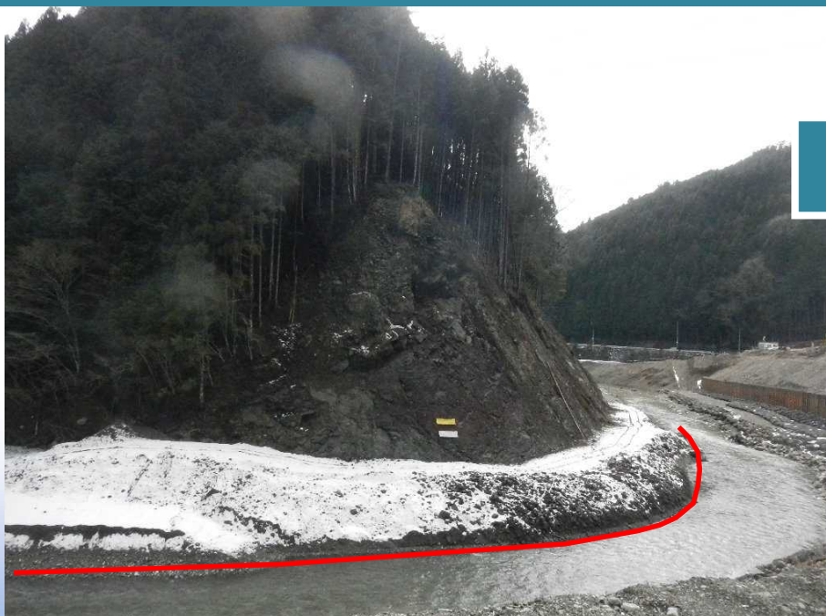
施工前(平成25年1月23日)
