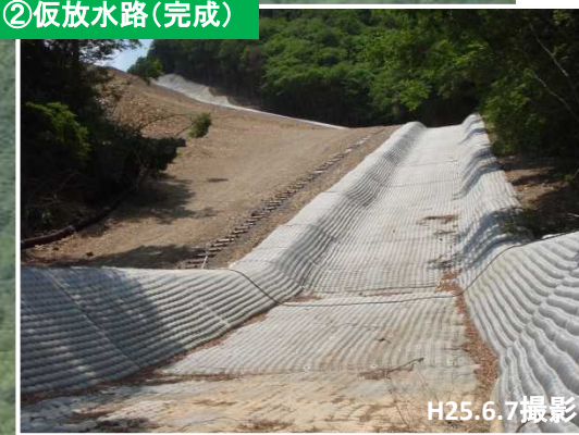
②仮放水路(完成)
