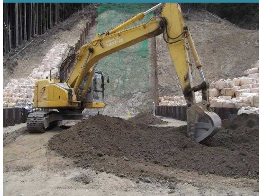
中詰材盛立状況(平成25年6月14日)
