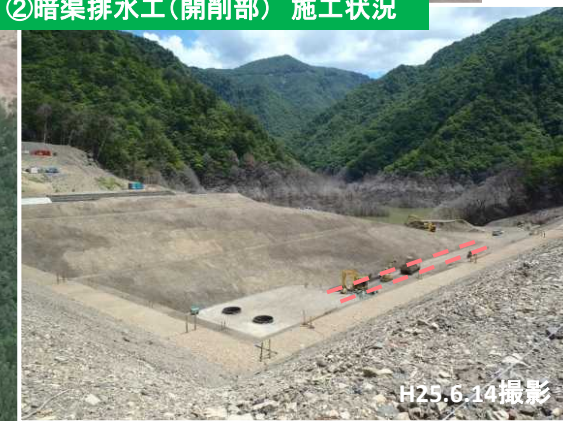
②暗渠排水工(開削部) 施工状況
