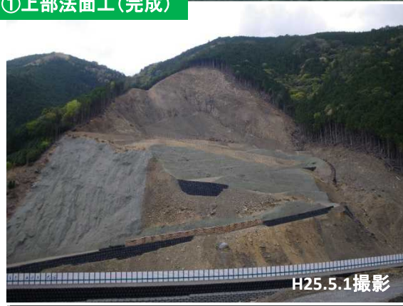
①上部法面工(完成)
