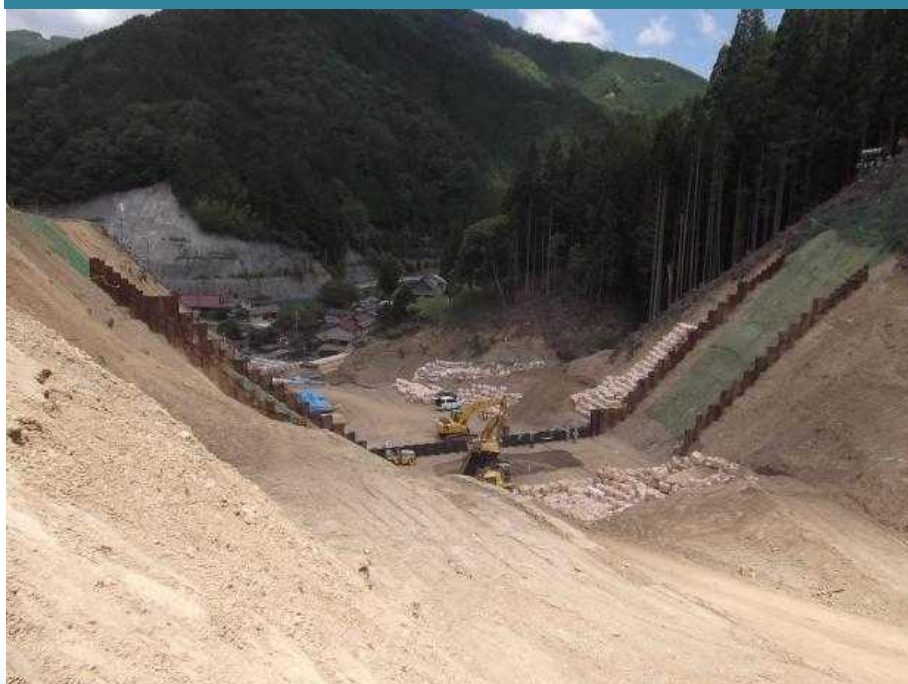
砂防堰堤工の施工状況(平成25年6月14日)
