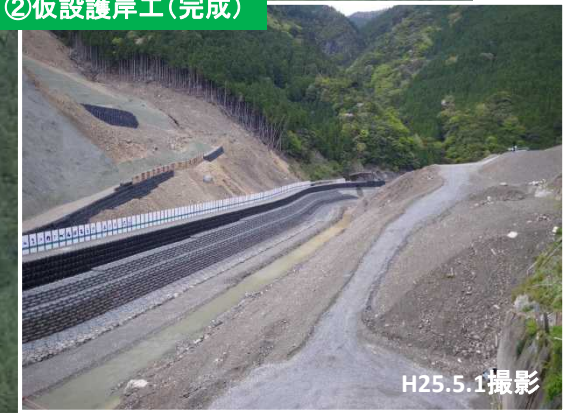
②仮設護岸工(完成)
