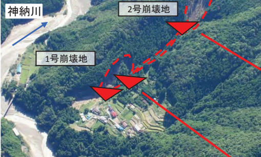
崩壊地が集落に近接
