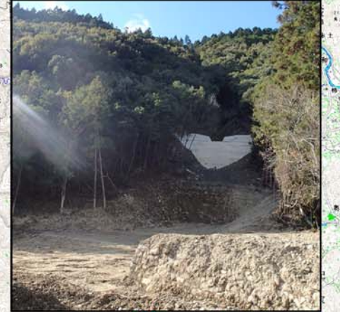
完成状況⑮(新宮市熊野川町九重和田)
