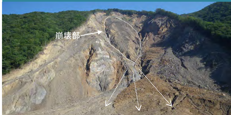
崩壊前（平成25年9月20日）
