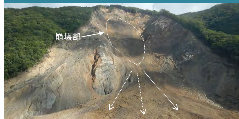
崩壊後（平成25年9月24日）
