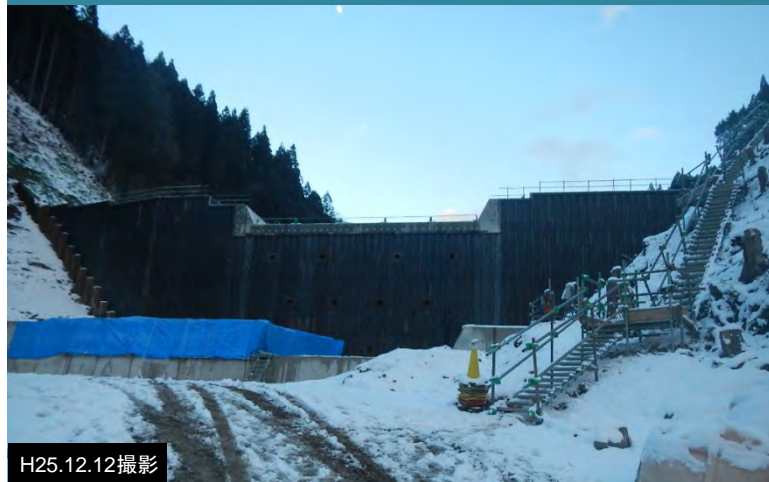
砂防堰堤工の施工状況(下流側より)
