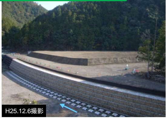
①砂防土工(残土整地) 施工状況
