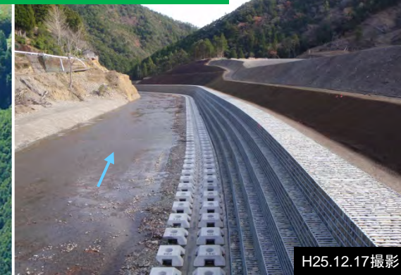
②流路護岸工 施工状況
