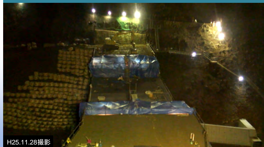
砂防堰堤工 夜間施工状況
