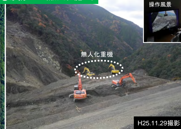
②砂防土工(無人化施工)
