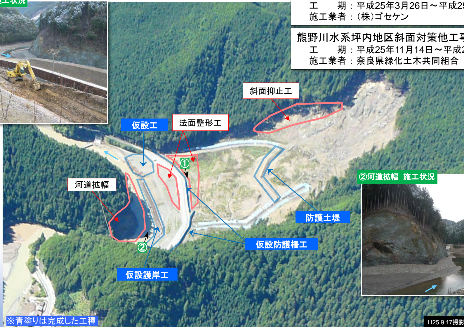
①法面整形工 施工状況
