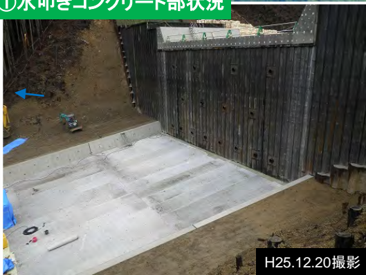
①水叩きコンクリート部状況
