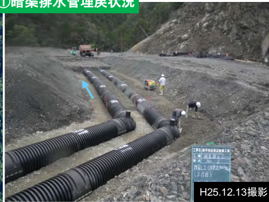
①暗渠排水管理戻状況
