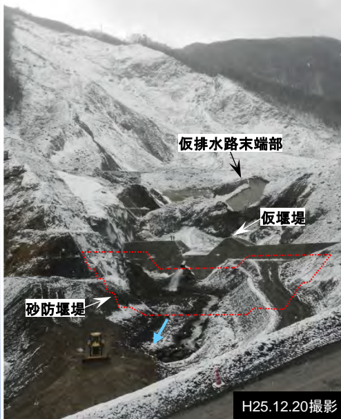
①掘削工(砂防堰堤施工に向けての仮堰堤施工状況)
