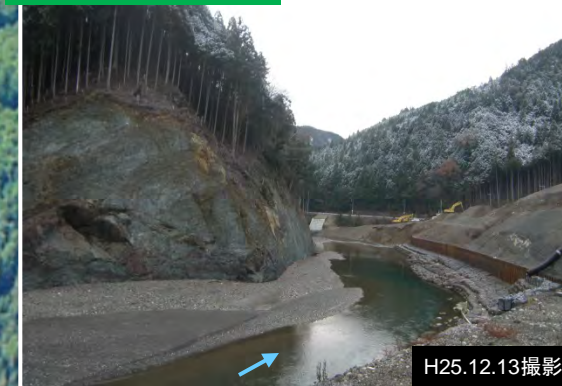
②河道拡幅 施工状況
