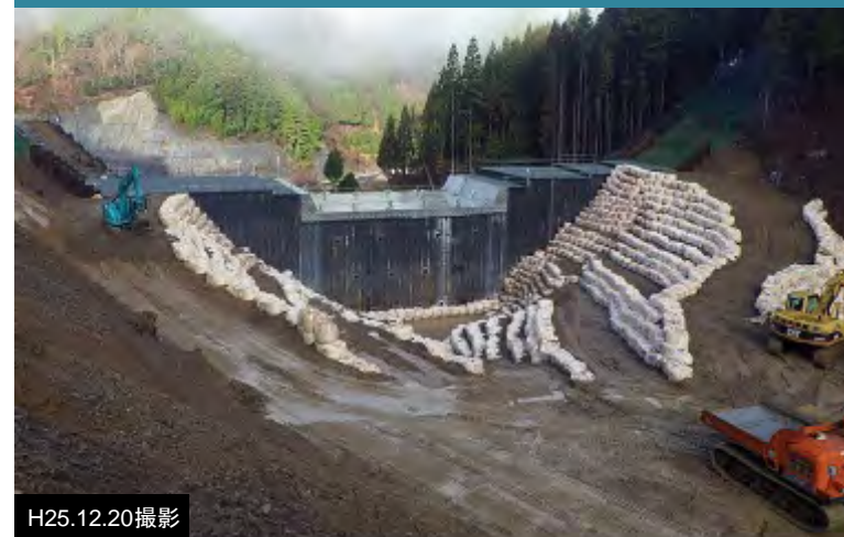
砂防堰堤工の施工状況(上流側より)
