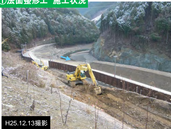
①法面整形工 施工状況
