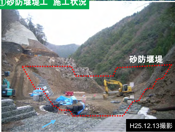
①砂防堰堤工 施工状況
